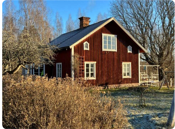
Huvudbyggnad med entréveranda. Vy från nordväst
