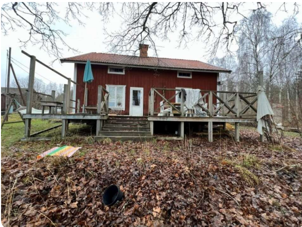
Huvudbyggnad med altandäck. Vy från syd
