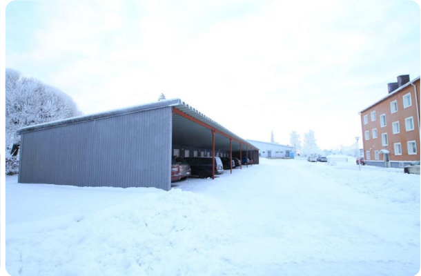
Foto parkering med carport, grå träpanel.
