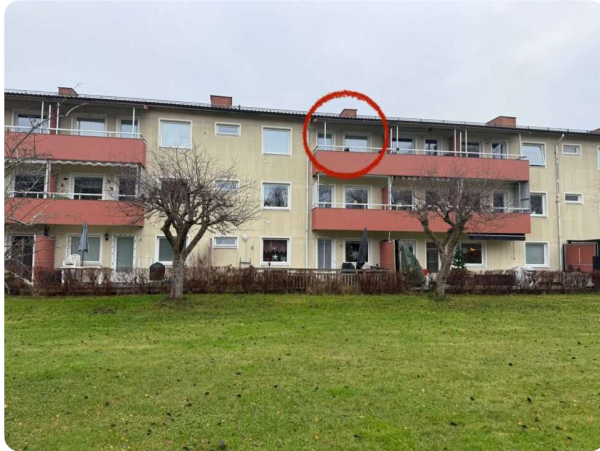
Huvudbyggnadens baksida. Värderingsobjektets balkong markerat.
