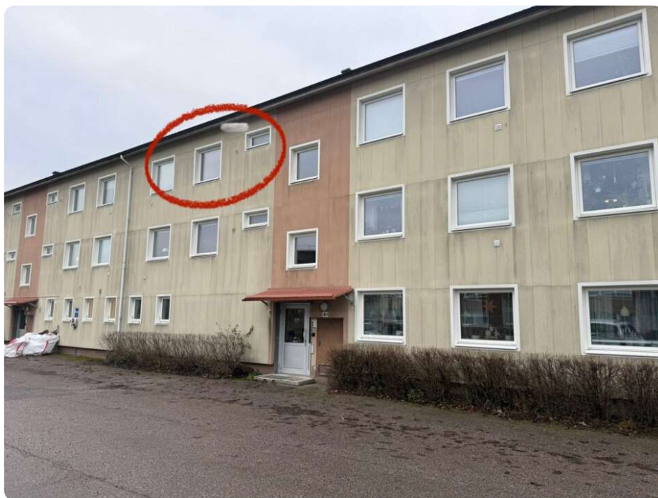
Huvudbyggnadens entré. Värderingsobjektet beläget på våning 3.
