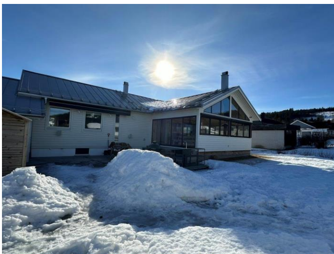
Foto, fasad mot baksidan med vit träpanel samt gråa och svarta detaljer. Tomt med snötäcke.
