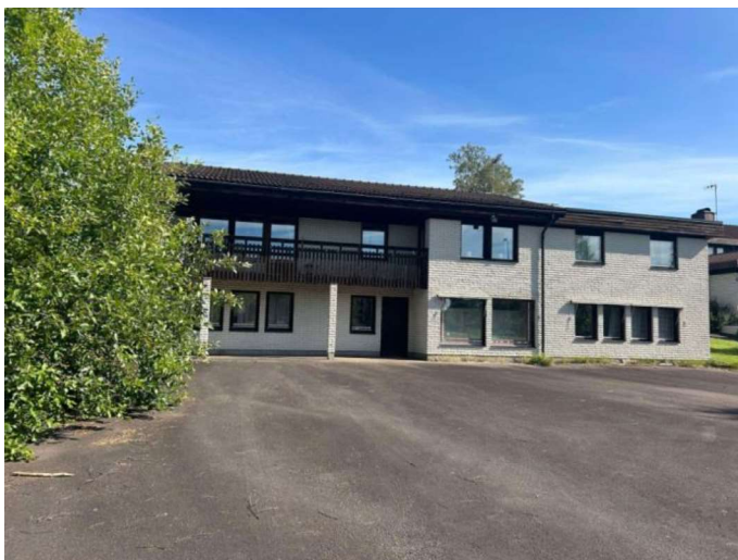
Foto, huvudbyggnaden med källarentré.
