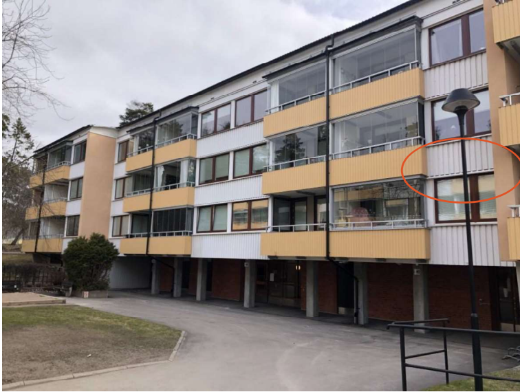
Foto, huvudbyggnad. Flerbostadshus i tre våningar med gul fasad och bruna/vita detaljer, värderingsobjektet markerat.
