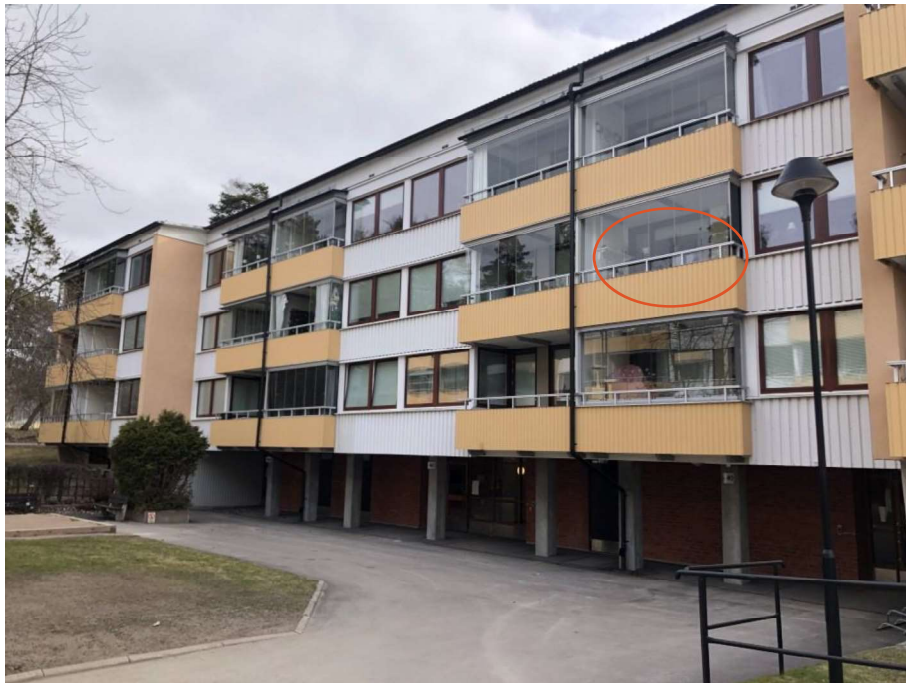
Foto taget utvändigt på värderingsobjektet. Foto taget utvändigt på värderingsobjektet. Flerbostadshus i tre våningar med gul fasad och bruna/vita detaljer, värderingsobjektet markerat.
