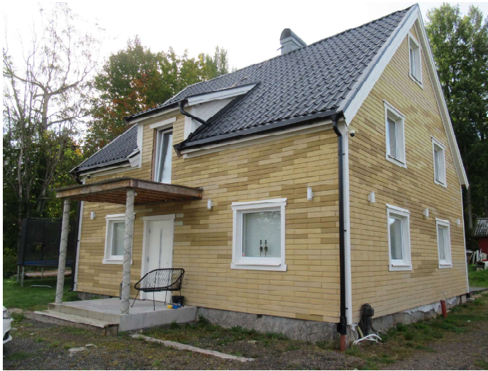
Foto, huvudbyggnad med tegelmönstrad fasadskiva och plåttak.
