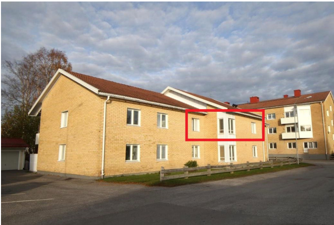
Foto, huvudbyggnad, Flerbostadshus i två våningar, med gul tegelfasad och vita trädetaljer
