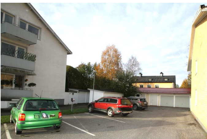
Foto, parkering, miljöhus gul träpanel gråa portar.
