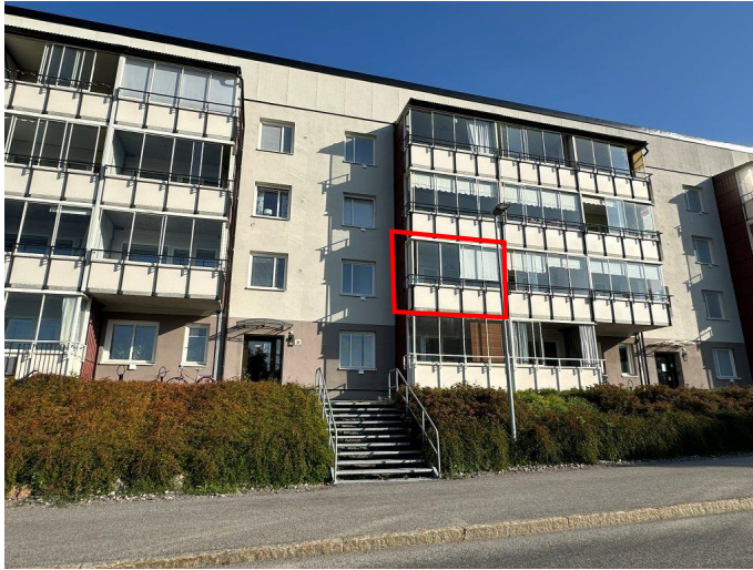
Foto, fasad mot Tjädevägen. Flerbostadshus i tre våningar samt suterrängvåning. Ljus putsad fasad och inglasade balkonger. Markeringen visar läget för värderingsobjektet.
