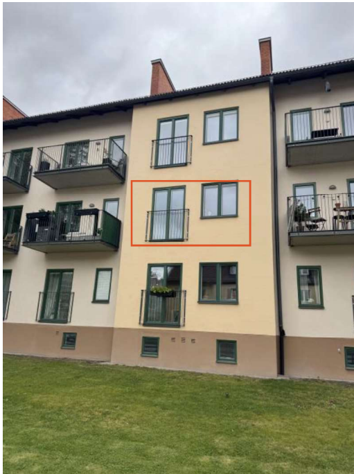
Foto, huvudbyggnad. Beigeputsad fasad. Lägenheten har fransk balkong
