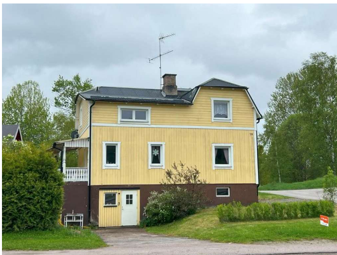
Foto, fasad mot nordost, f.d garage med ny ingång.
