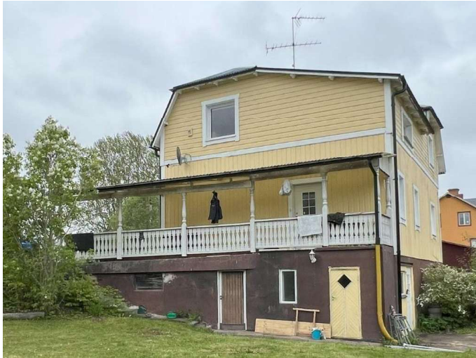
Foto, fasad mot sydost, takad altan med entrédörr.
