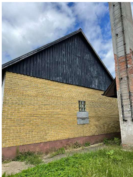
Bild 13: Ekonomibyggnad 2 från öst
