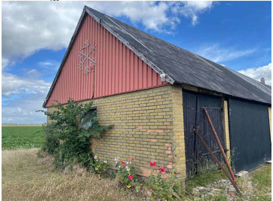
Bild 6: Ekonomibyggnad 1 från väst
