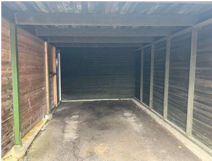
Foto, carport, asfalterad
