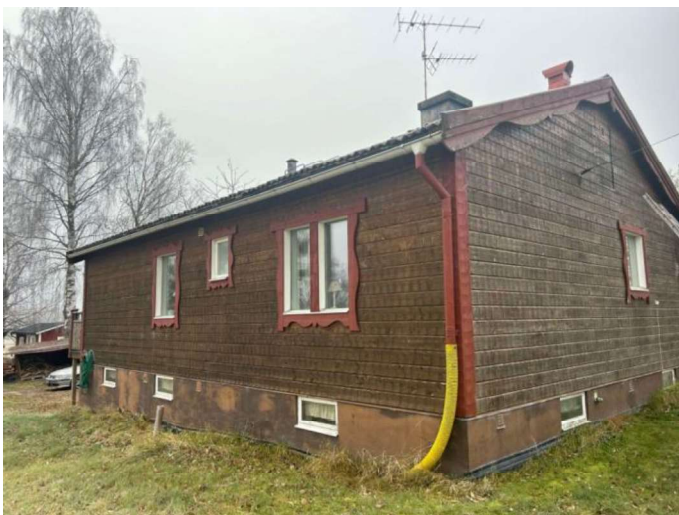
Foto, vy över byggnadens baksida.
