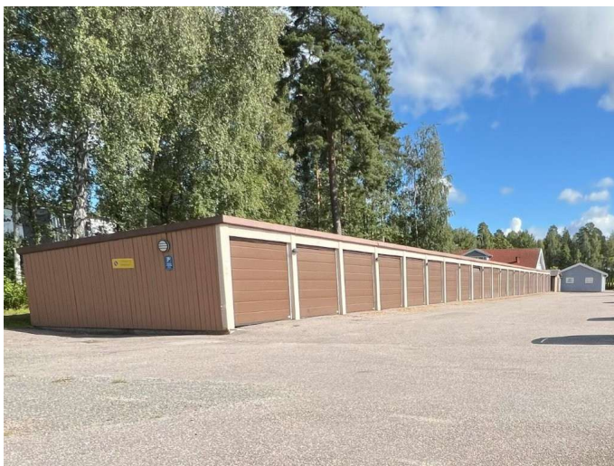
Foto. Föreningens garage (22 st).
