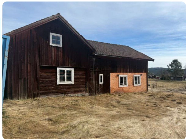
Övrig byggnad, f.d. ladugårdsbyggnad
