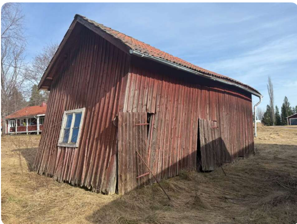
Övrig byggnad, förråd.
