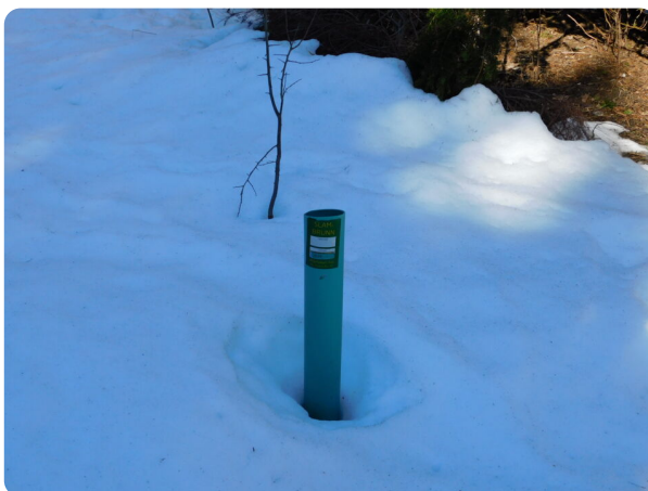
Slambrunn, avluftningsrör.
