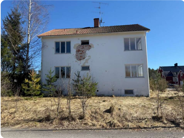
Huvudbyggnadens baksida med ljus putsfasad som släppt.
