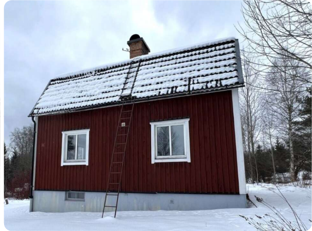
Bostadens fasad (äldre delen) mot nordöst.
