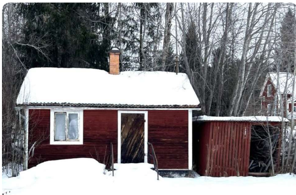
Stuga (renoveringsprojekt) och liten vedbod.
