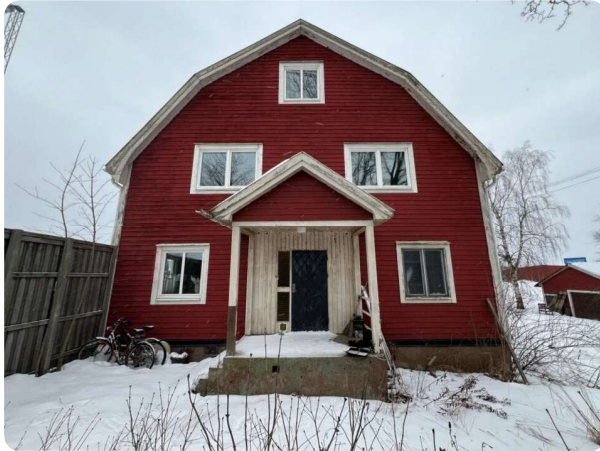
Bostadshusets entré på kortsidan mot väst
