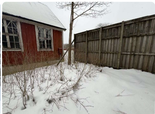
Insyns- och ljudskydd mot landsvägen vid entrésidan mot väst
