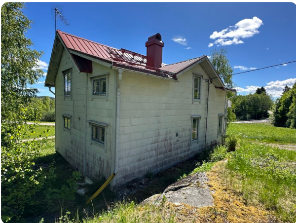
Fasad med ljusa eternitplattor samt rött plåttak
