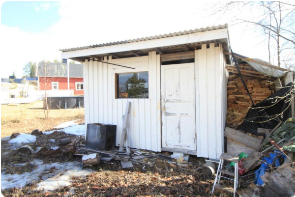
Foto vedförråd, vitmålad träpanel med vita detaljer,
