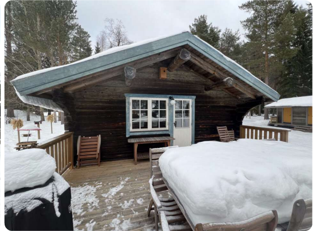
Huvudbyggnadens fasad mot syd, med stort altandäck.
