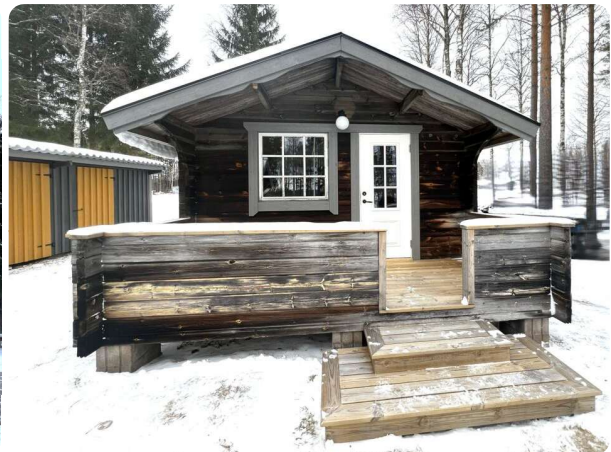
Gäststuga med el och värme
