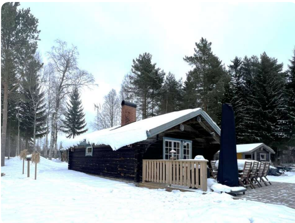
Huvudbyggnadens fasader mot sydväst
