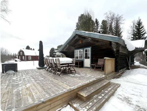
Huvudbyggnadens fasader mot sydost
