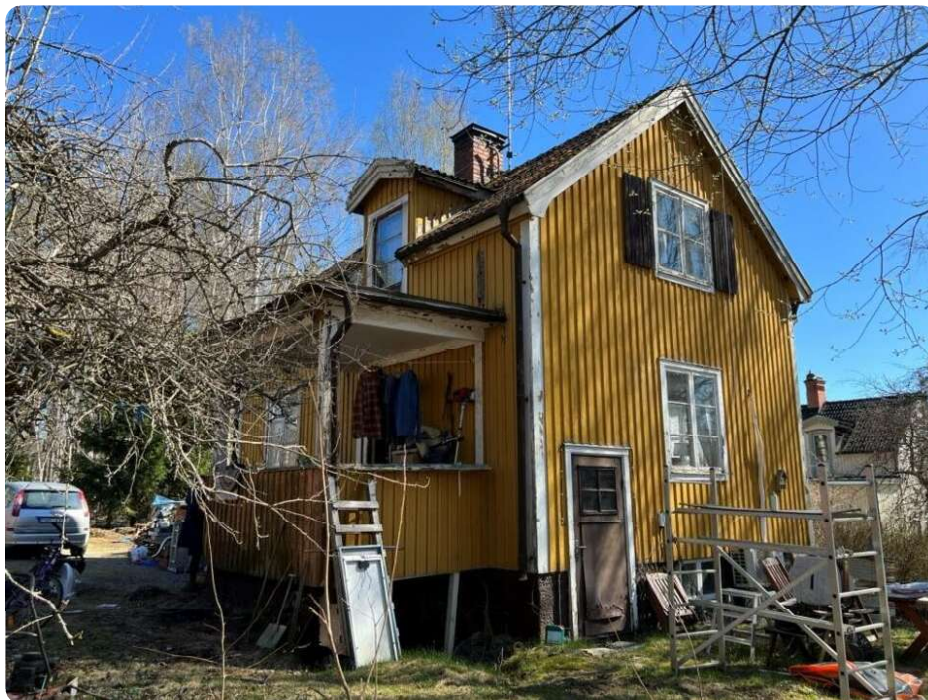
Bostad sedd från nordväst
