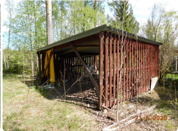
Foto övrig byggnad, carport, träkonstruktion med pulpettak i plåt.
