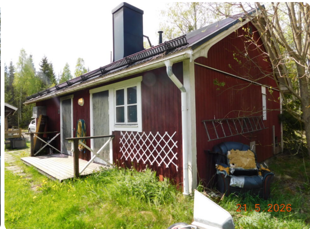
Foto övrig byggnad, garage m.m., baksida, rödmålad träfasad med vita detaljer.
