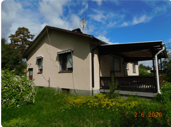
Foto huvudbyggnad, gråputsad fasad, altan med tak.
