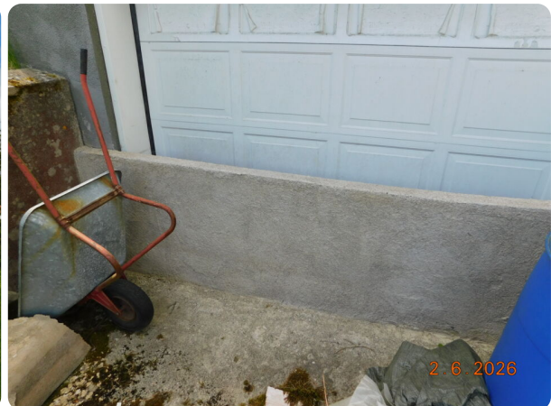
Garageport, blockerad, förmodligen utfört för att hålla bort dagvatten.
