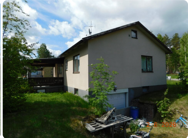
Foto huvudbyggnad, gråputsad fasad, altan med tak.
