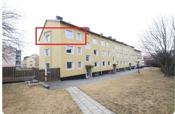
Foto huvudbyggnad, gul plåtfasad, vita detaljer.
