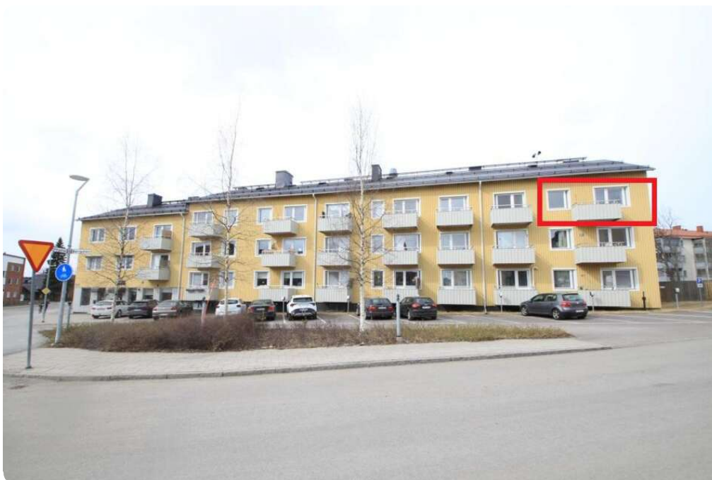
Foto huvudbyggnad, gul plåttfasad, vita detaljer.
