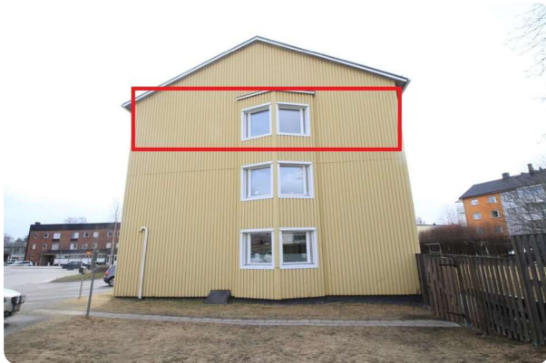
Foto huvudbyggnad, gul plåtfasad, vita detaljer.
