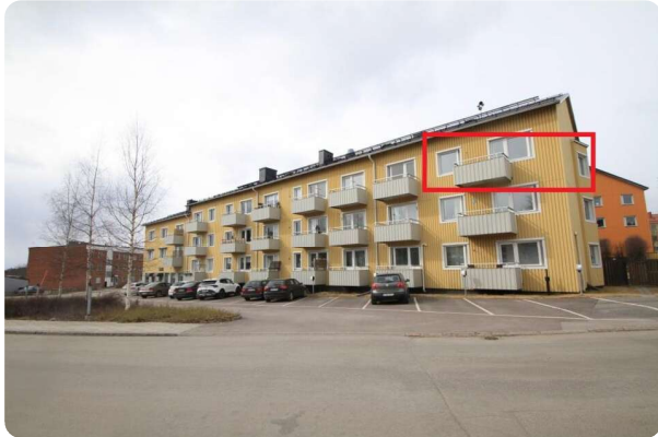
Foto huvudbyggnad, gul plåtfasad, vita detaljer.
