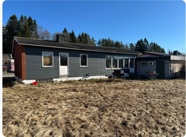
Fasad mot baksidan med grå träpanel och rött tegel samt vita detaljer
