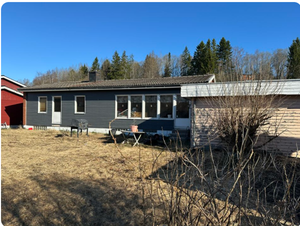
Fasad mot baksidan med grå träpanel och rött tegel samt vidbyggt garage med ljus träfasad
