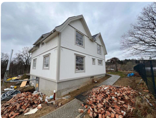
Bostadshus med vit fasad och grå detaljer samt byggmaterial/bråte
