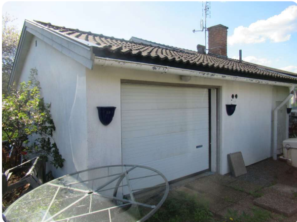
Garage i anslutning till huvudbyggnad
