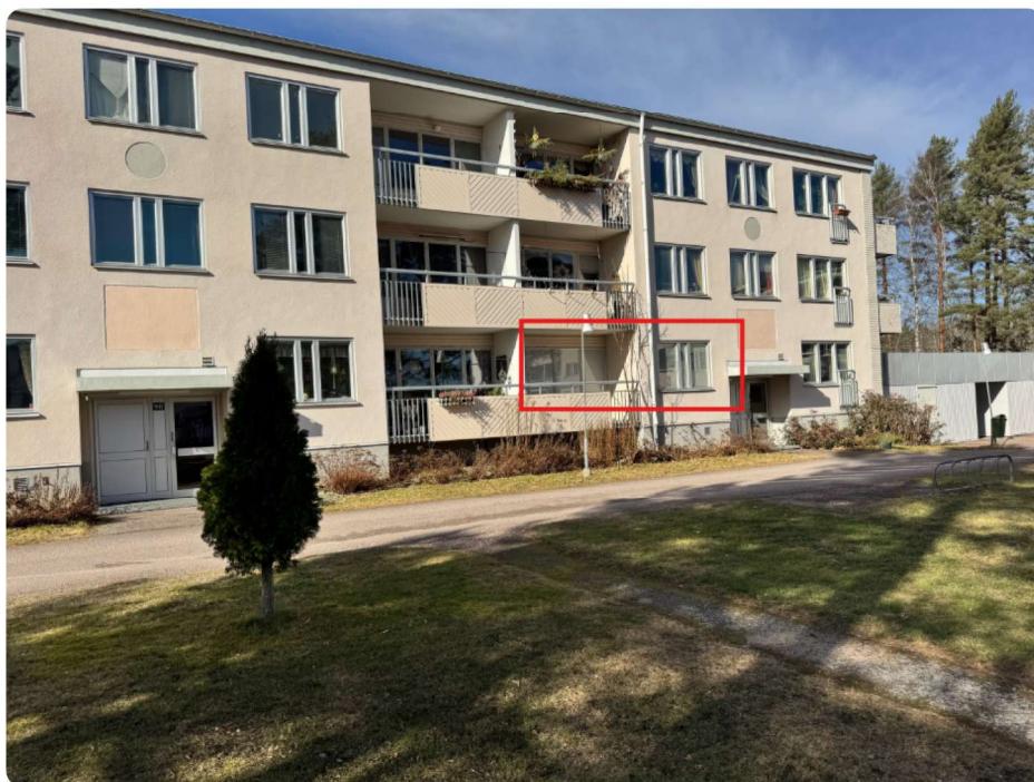
Huvudobjekt, flerbostadshus med ljus fasad
