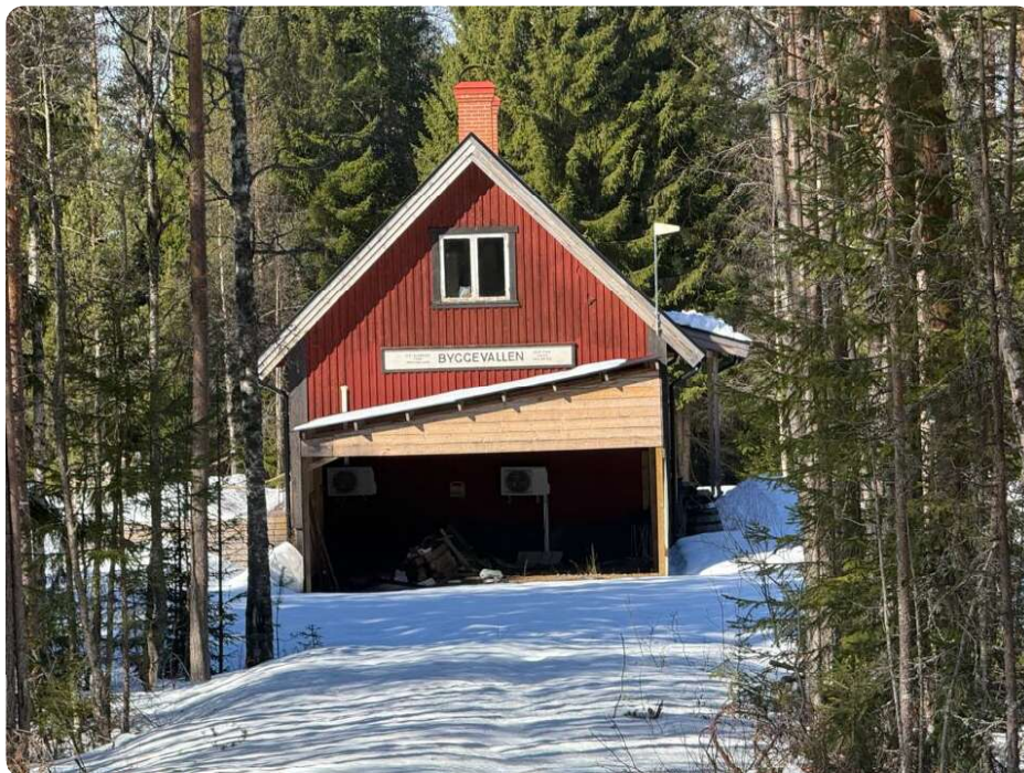
Översiktsbild av värderingsobjektet. Bild tagen från fastighetens infart.
