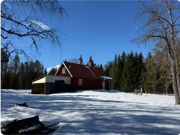
Översiktsbild av värderingsobjektets huvudbyggnad och tomtmark
