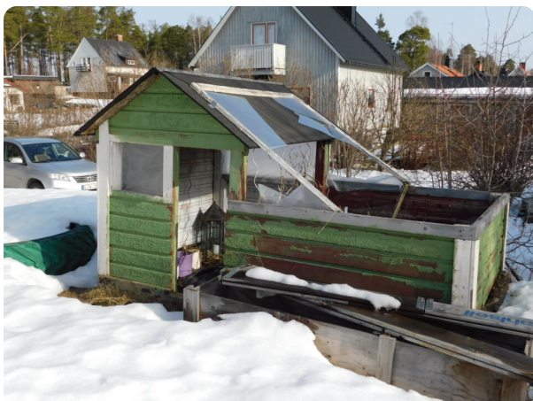
Övrig byggnad, fasad med grön träpanel och tjärpaptak.
