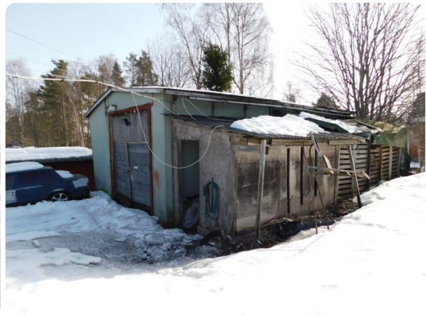
Garage samt vidbyggt förvaringsutrymme.
