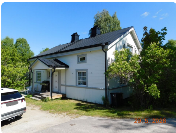
Foto huvudbyggnad, entré via farstuvist, ljusmålad träfasad med gråa detaljer och plåttak.
