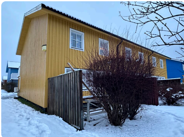
Fasad mot baksidan med gulmålad träpanel och vita detaljer
