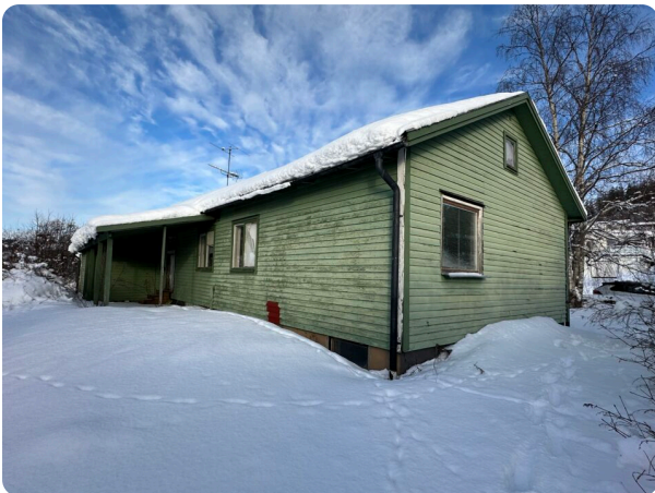
Fasad baksidan av bostadshus med grön träpanel. Tomt med snötäcke
