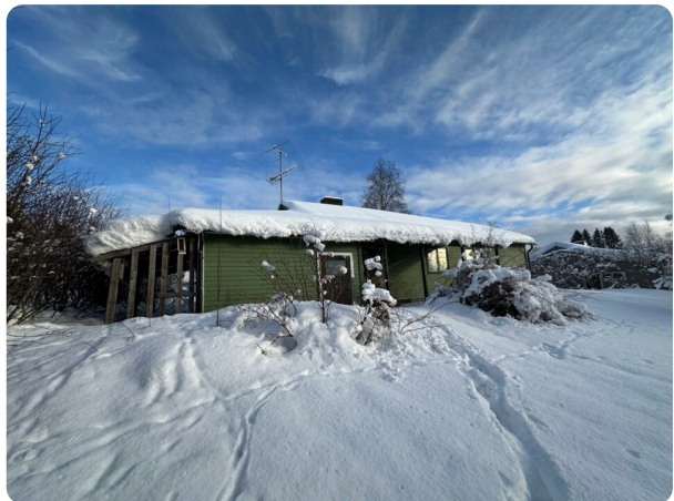
Fasad baksidan av bostadshus med grön träpanel. Vidbyggt garage samt enkelt skärmtak.
