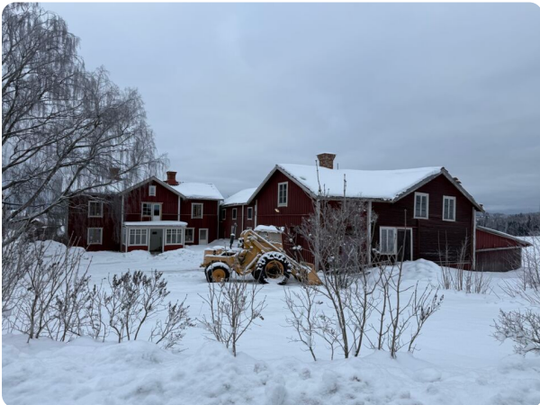
Översiktsbild. Bostadshus och övriga byggnader i rödmålad träpanel med vita detaljer.
