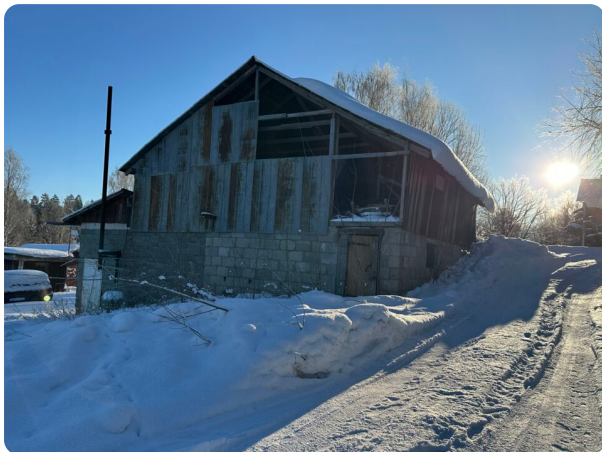
Gavel av garage/verkstad/förrådsbyggnad med murad fasad samt överbyggnad i trä
