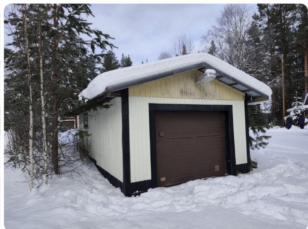
Garaget med plåtfasad
