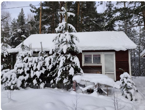
Framsidan av huvudbyggnaden
