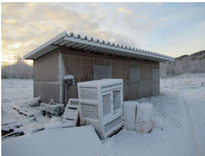
Foto, Byggnad som ej tillhör fastigheten
