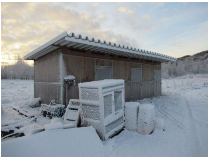
Foto, Byggnad som ej tillhör fastigheten
