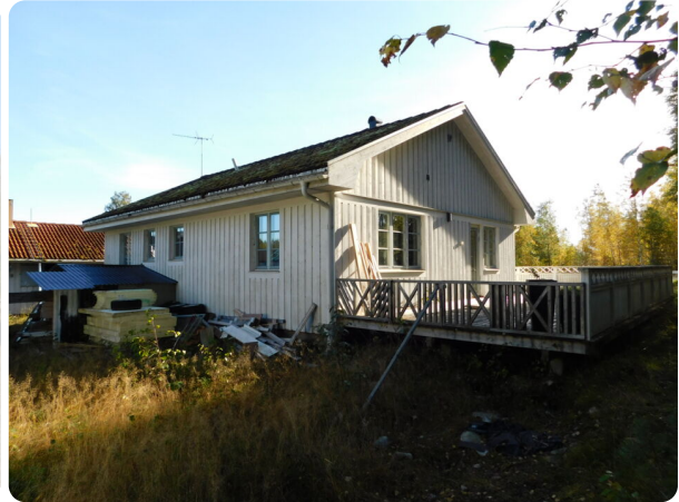
Baksida, altan i trä vid byggnadens södra kortsida.
