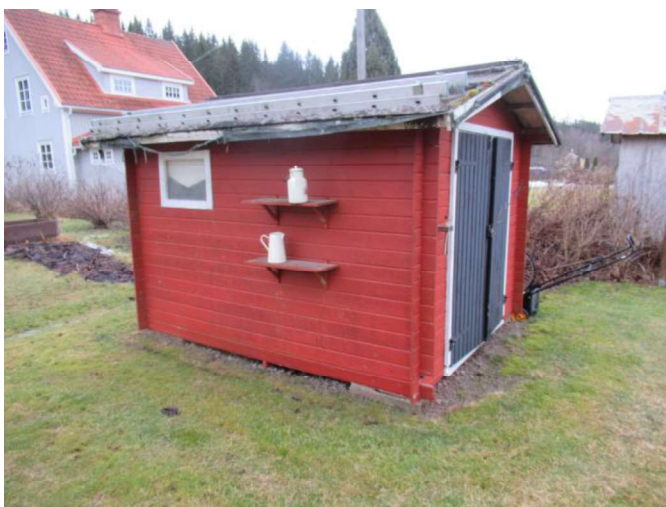
Foto, mindre förrådsbyggnad.
