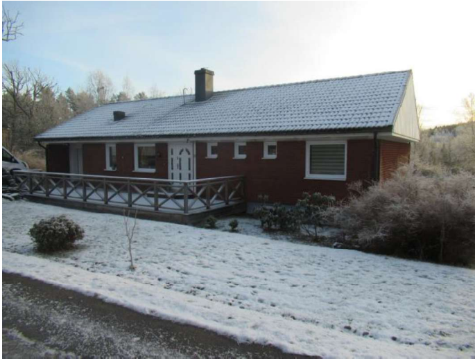
Foto, huvudbyggnad från framsida med en mindre altan i anslutning till entrén.
