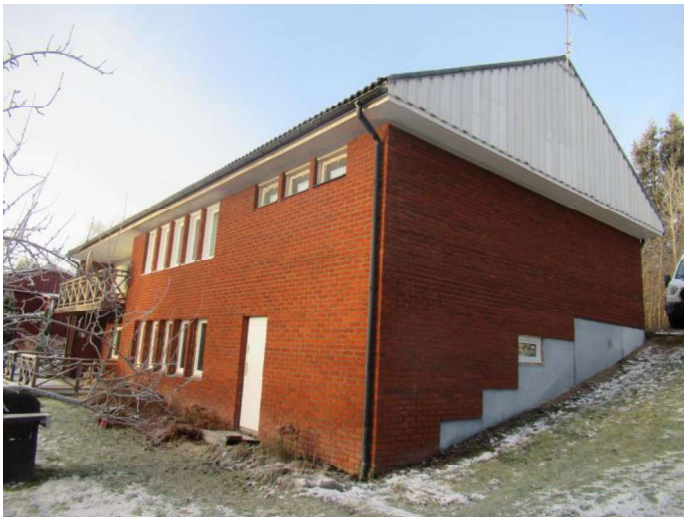
Foto, tegelbyggnad i suterräng med garagedel till höger i bild.
