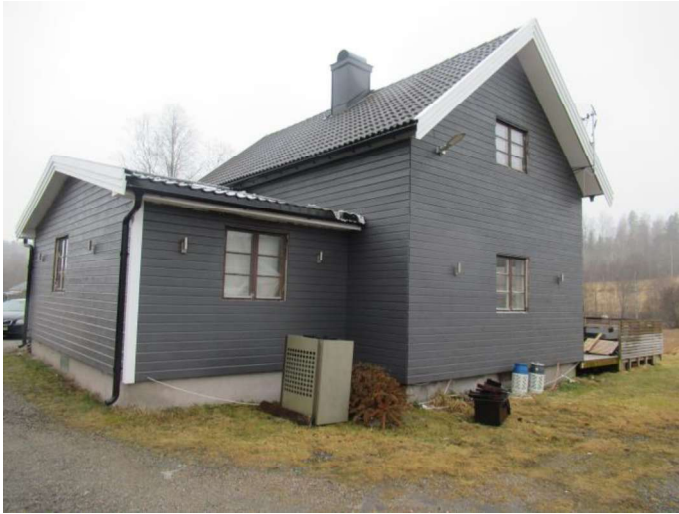
Foto, huvudbyggnad från parkering.
