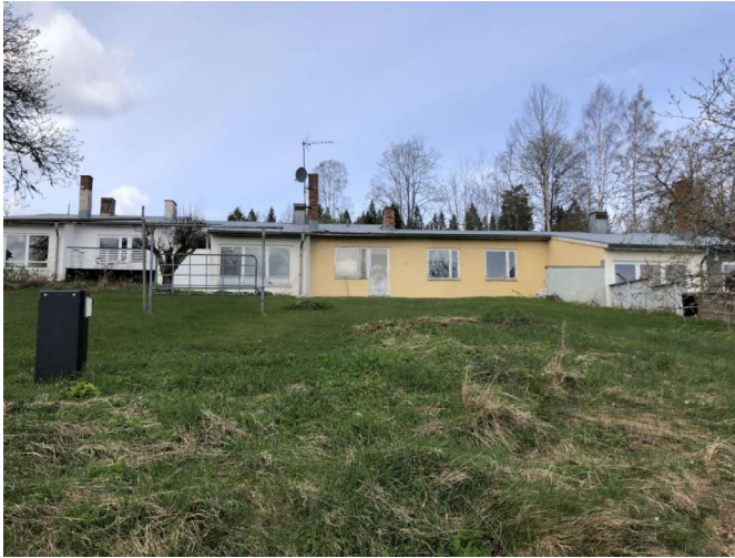
Foto, byggnad. Byggnad av radhustyp med grå och gul fasad samt sluttande mark med gräsmatta. Vy från baksidan
