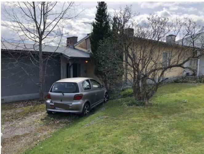
Foto, byggnad. Byggnad av radhustyp med grå och gul fasad. Vy från entrésidan.
