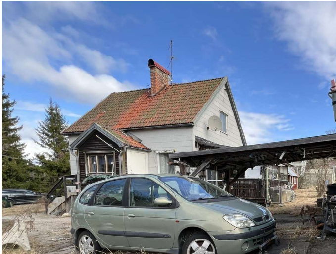
Foto, huvudbyggnad, fasad med eternitplattor.
