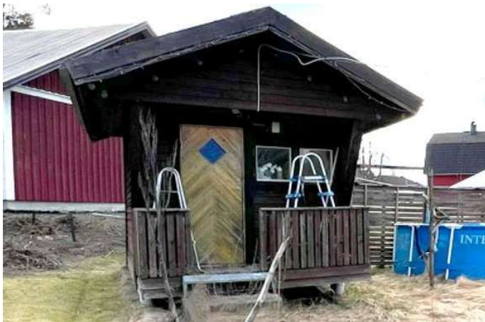
Foto, byggnad 4, friggebod.
