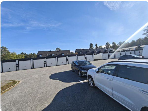
Foto parkering med garage och öppna platser.
