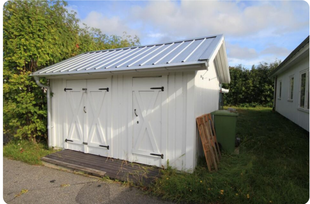
Foto, förråd , vitmålad träpanel och plåttak.
