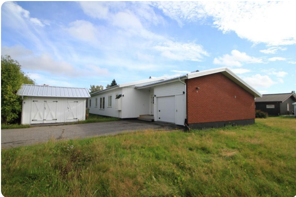
Foto huvudbyggnad, med vidbyggt garage.
