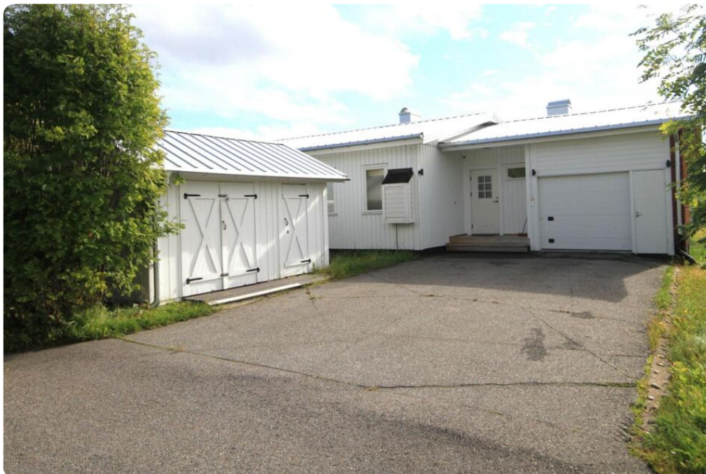
Foto, huvudbyggnad fasad med ljus träpanel.
